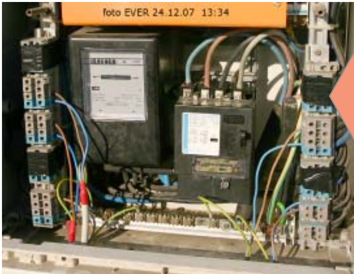
Deur van de werfkast niet slotvast, panelen die onder spanning staande delen beschermen vallen op de grond bij het openen van de kast. Bescherming door omhulsels art. 34 - art. 35 (inbreuken niet limitatief).
