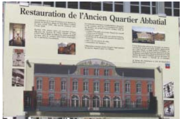
Het "Palais Abbatial" in restauratie
