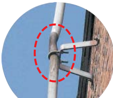
Draagbuis van een radioactieve bliksemafleider
