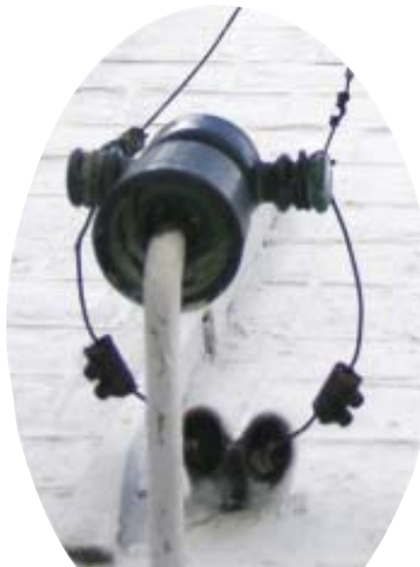
Niet geïsoleerde geleiders met "lusterklemmen" op minder dan 2,5m. van het voetpad.
