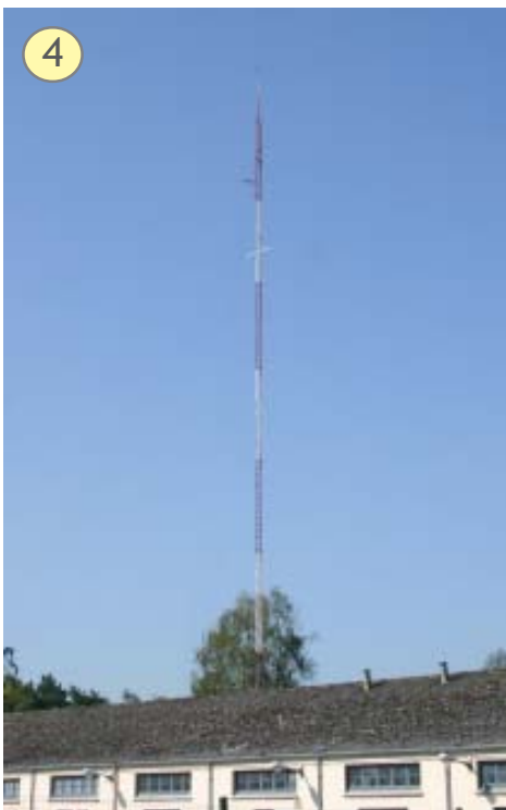
Mast Civiele veiligheid te Ghlin (48m) en niet eens een fatsoenlijke bliksembeveiliging
