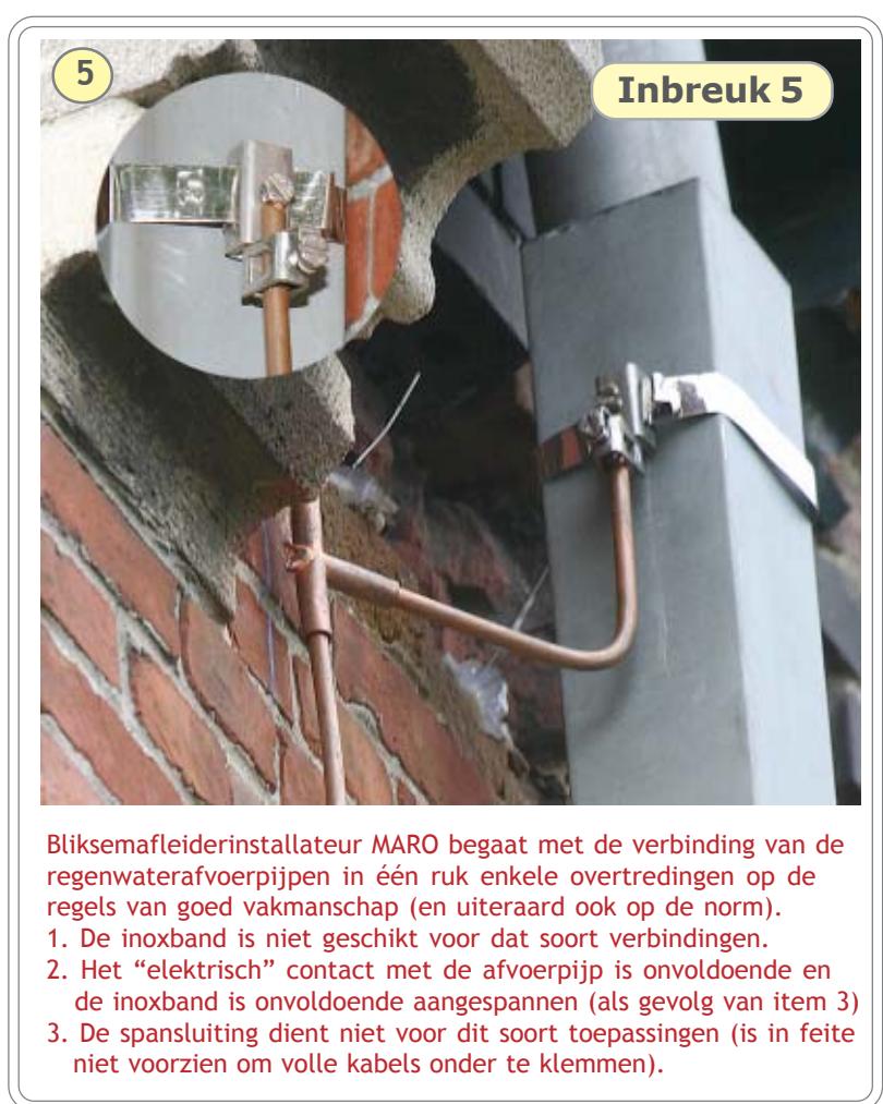
Deze afvoerpijp is aan de bovenkant niet met de daalleiding verbonden.
