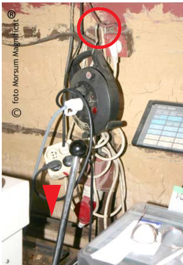
De draden hangen met een metalen haak aan de kabel van het stopcontact (cirkel) de kabel van de deegmenger is als een violsnaar gespannen (Pijl)...
