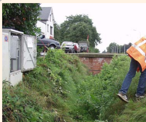
Een installatie van Telenet <kast links> die je als technicus pas kan bereiken door eerst de hindernis van de gracht te nemen, ook als er water in staat ! Waarom doet de vakbond daar niets aan ?
