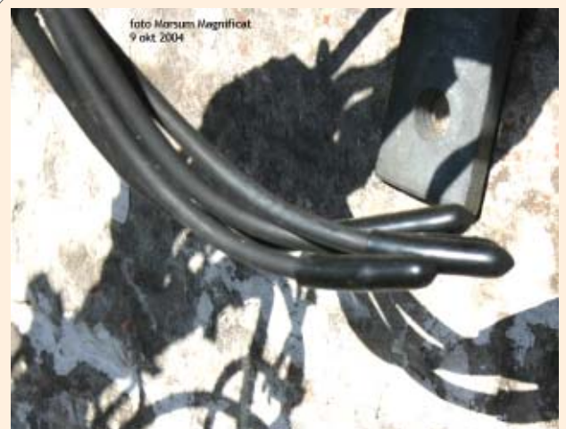
De eindmoffen zijn in ieder geval niet zo oud als de kabel zelf, ze blinken nog als nieuw !
