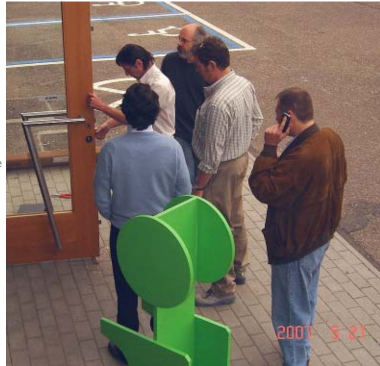
De houten spie onder de deur moet de plaatsing wat gemakkelijker maken ...
