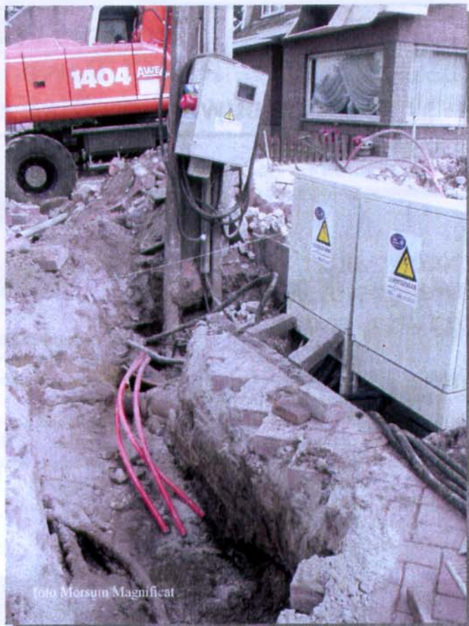
Wegens problemen met de riolering werden nieuwe kabels voorzien. <rood gekleurde kabel>
