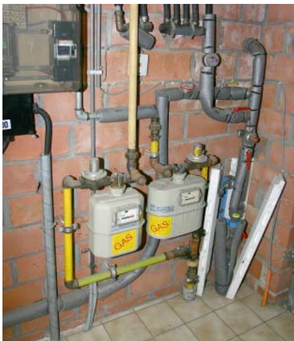
De equipotentiaalverbindingen tussen water- en gasleidingen zijn niet gemaakt (art. 72.01 AREI).
