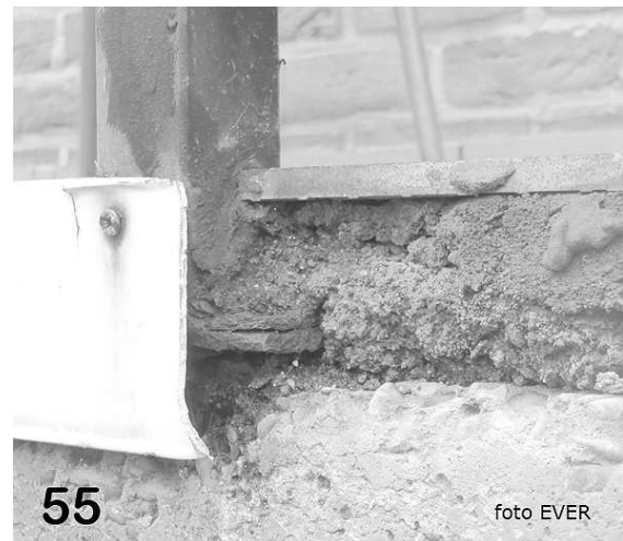
7.4. Sommige vierkante buizen van de leuning van het terras vertonen op diverse plaatsen roest, sommige profielen zijn zelfs doorgeroest -inzet foto 54 -.
