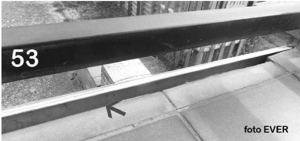
7.3. Ook een 2 e lat is grotendeels losgekomen -inzet foto 53 -
