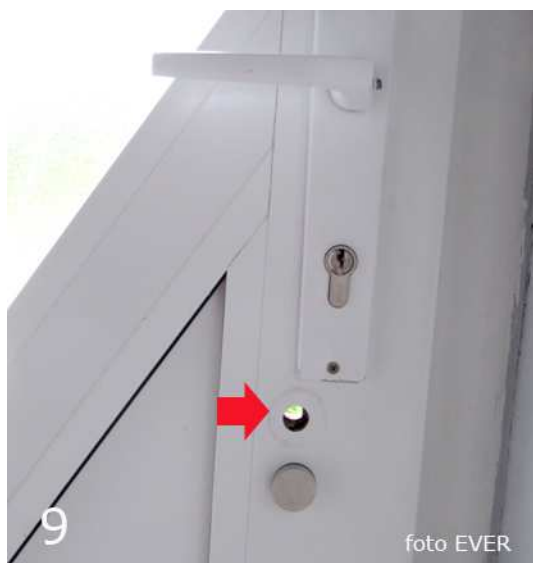
2.10. Voordeur binnenkant: plastic afschermplaat bevestiging / regeling ontbreekt -inzet foto 10-
