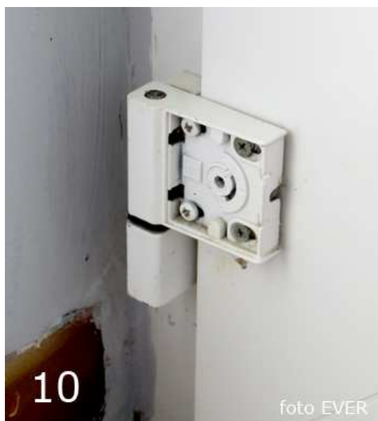
2.10. Voordeur binnenkant: plastic afschermplaat bevestiging / regeling ontbreekt -inzet foto 10-
