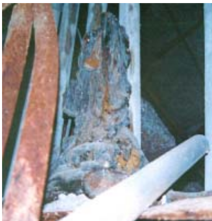
Gesmolten beton druppelde als lava tussen verwrongen onderliggende constructies
