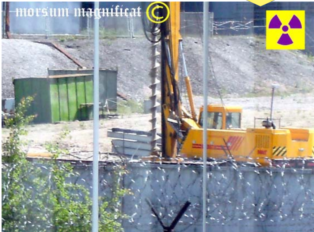
Boren van funderingen voor spoorlijn door de 6 meter dikke kleilaag die het hoog radioactief materiaal afdekt
