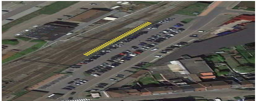
Parking Cristal Monopole wordt blauwe zone met 4 uur parkeertijd die toegestaan is met bewonerskaart. In september wordt door de NMBS gestart met de bouw van bewaakte en overdekte fietsstallingen -zie geel gearceerde annotatie- foto Google / repro EVER
