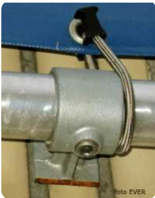
Bevestiging van het aluminium frame die "muurvast" tegen de gevel zit en niet verwijderd kan worden.
