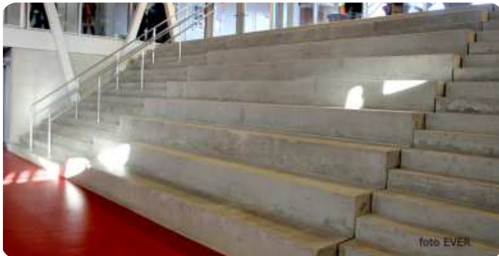
Over deze situatie -trappen en leuning- mag WASO zich wel eens buigen.
