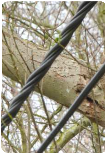
Diverse bomen en takken ter hoogte van huisnummer 107 bedreigen het luchtnet.
