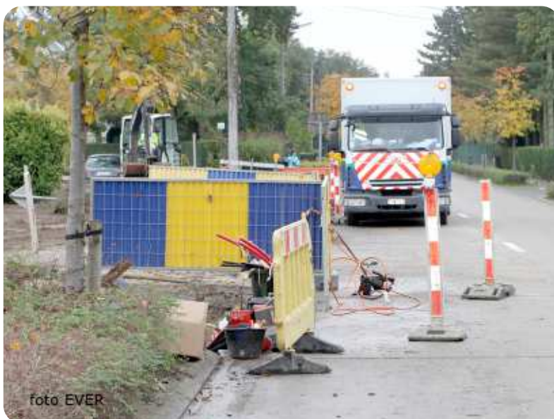
Eandis -het blauwe Open-Vld fabriekje- tijdens de herstelling van het hoogspanningsdefect in de Grote Bollostraat
