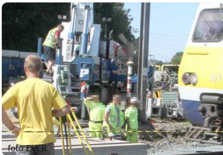
Binnen de draaicirkel van de kraan maar toch niemand die een helm draagt. Bij een voorbijrijdende trein blijven de werknemers op minder dan twee meter van de trein post vatten.
