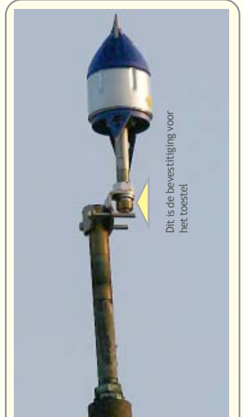
De Prevector werd bevestigd met de klem die dient om de daalleiding tussen te klemmen.
