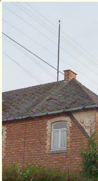
De Franklin staaf met de radioactieve Helita A Calotte een nooit onderhouden installatie uit 1956.
