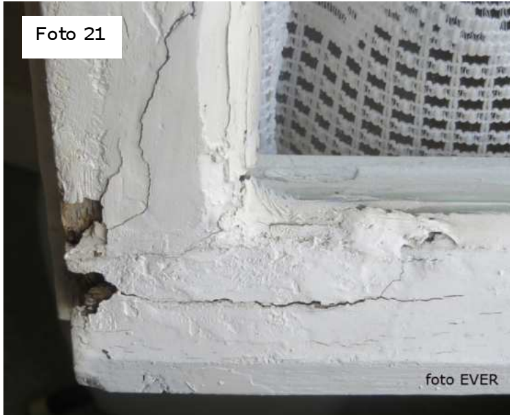
Houtrot verwijderd en opgevuld met stopverf.
