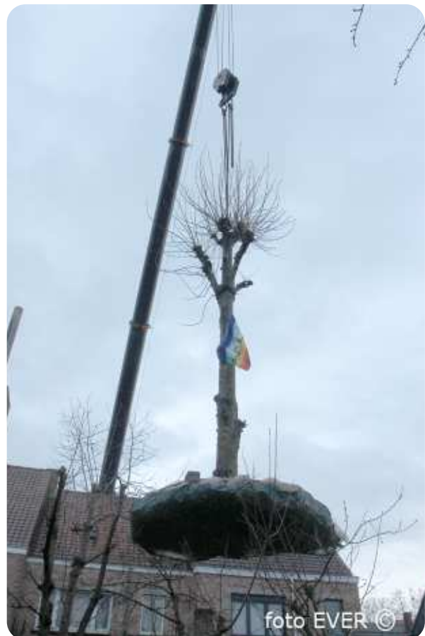
De eerste Esdoorn wordt om 09:30u. met de ingepakte kluit aarde, over de daken gehesen, het gewicht was iets meer dan 5.000 kg.
