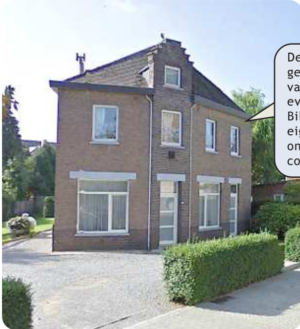
De 1e verdieping is al geruime tijd ontruimd, nu is de woning slechts ongeschikt verklaard
