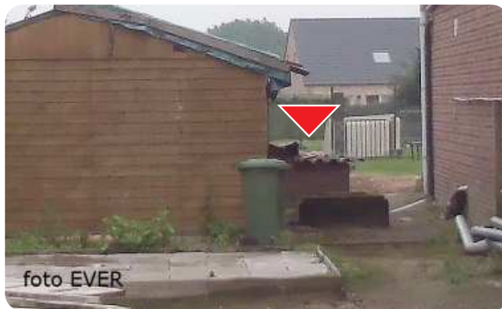
De half bovengrondse, half ondergrondse stookolietank is gezamenlijk voor de twee appartementen, wie het meeste gebruikt is niet te bepalen!
