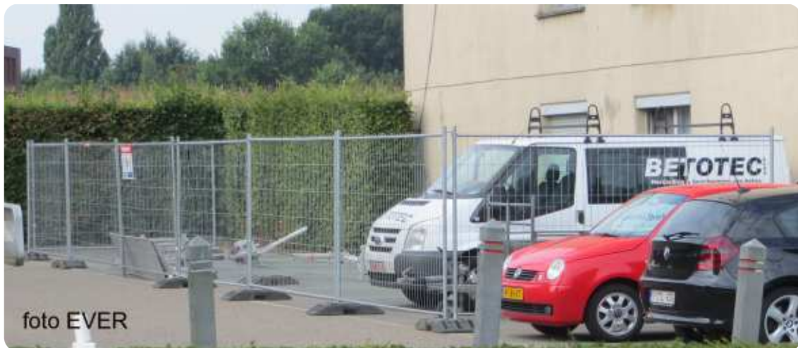
Betotec heeft voor het volgende deel van haar werf een afsluiting geplaatst, zó moet dat.
