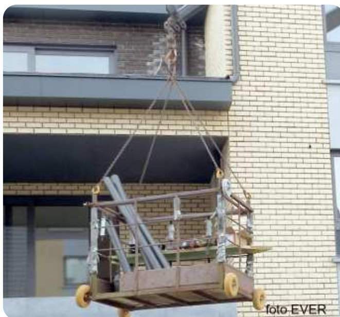
De hijskooi zou volgens Moors gekeurd zijn voor 500 kg last. Wij hebben geen identificatieplaat gezien.
