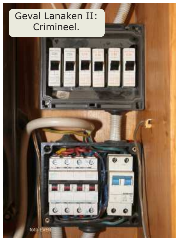
Geval II. Geen differentieel of beschermingsgeleider te bespeuren, wel stopcontacten met aarding voor een wasmachine!
