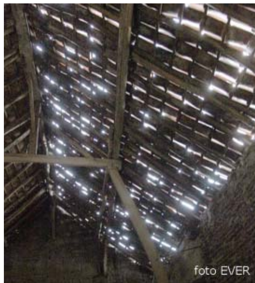
Dit is het achterste dak van de schuur waarvan de eigenaar beweert dat het er niet binnen regent, uiteraard onzin.
