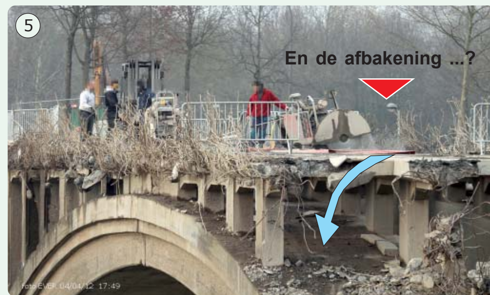
Betonzagen zonder vereiste PBM - afbakening brug onbestaande of onveilig ...
