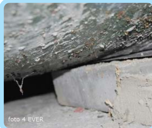
Foto 4 Betonnen steunbalk 1 onderkant.
