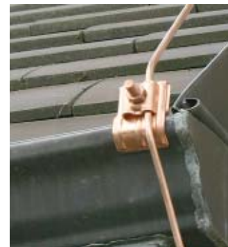
Verbinding van een koperen dakgoot.
