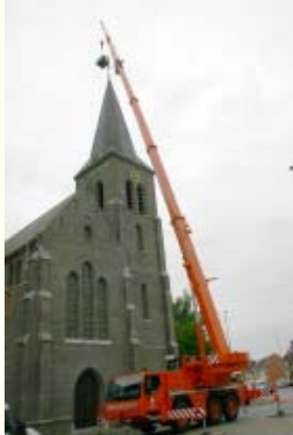
26.07.2005 - Eglise Kwatrecht - Grue Michielsens - Helita A Pastilles enlevé - Tige Franklin installé
