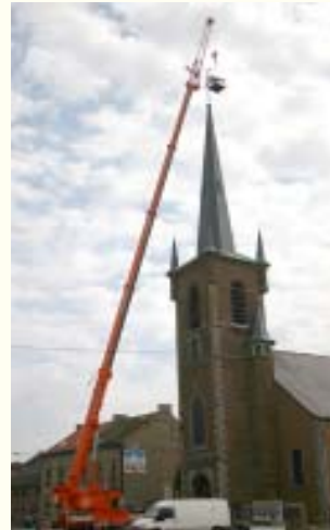
18.07.05 - Eglise Gozée Grue Michielsens 70T - Copie Horemans- Souply enlevé
