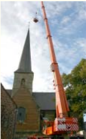
26.09.2005 - Westrem - Eglise - Grue 90T Michielsens - Preventor Indelec enlevé
