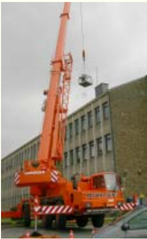
30.09.2005 - Athenée Libramont <Av. Herbofin> - Grue 50T Michielsens Manage - Grensson enlevé
