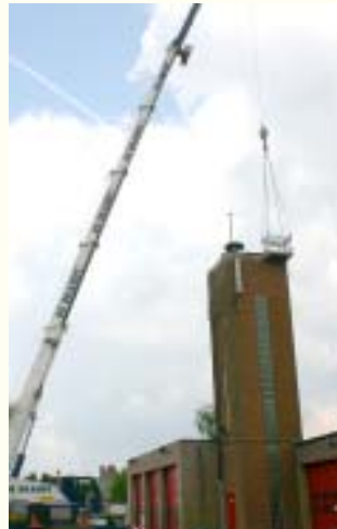
31.05.2005 - Zele - Bâtiment Pompiers / Sapeurs - Grue De Brandt. Preventor Indelec enlevé.
