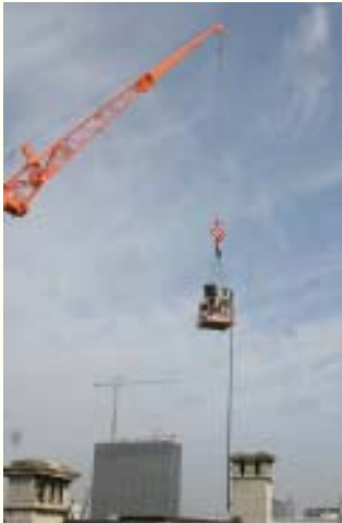
23.05.2005 - Bruxelles - Palais des Nations - Grue 70T Michielsens - Combinator enlevé
