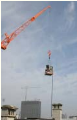
23.05.2005 - Bruxelles - Palais des Nations - Grue 70T Michielsens - Combinator enlevé
