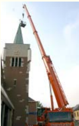
13.07.2005 - Hofstade (Malines) - Grue 40T Michielsens - Preventor Indelec enlevé
