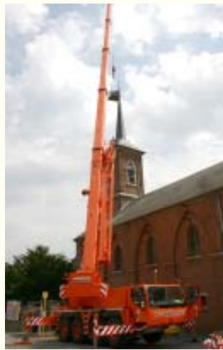
18.07.05 - Eglise Leers et Fousteau Grue Michielsens 70T - Copie Horemans-Souply enlevé
