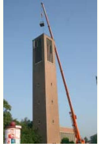
30.08.2005 - Arendonk - Eglise St Joseph - Grue 90T Michielsens - Preventor Indelec enlevé
