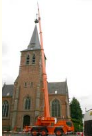
26.07.2005 - Eglise - Appelterre - Grue 50T Michielsens - Preventor Indelec enlevé - Tige Franklin installé
