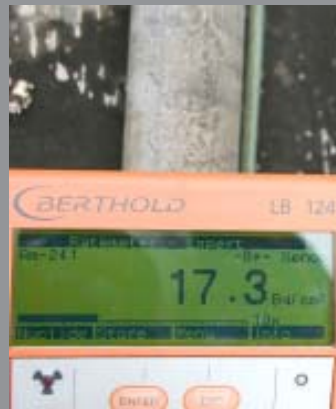
Tube contaminé (mesuré avec un moniteur de contamination)
