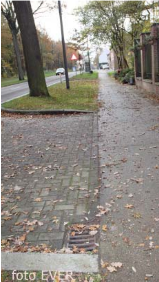
Via de rioolmondingen wordt een verpestende stank verspreid.
