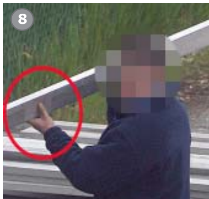
Geen handschoenen bij het manipuleren van -zware- metalen profielen of het manipuleren van opgespannen stalen kabels -foto 9-.
