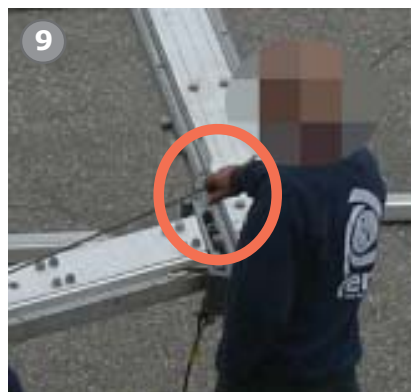
Geen handschoenen bij het manipuleren van -zware- metalen profielen of het manipuleren van opgespannen stalen kabels -foto 9-.
