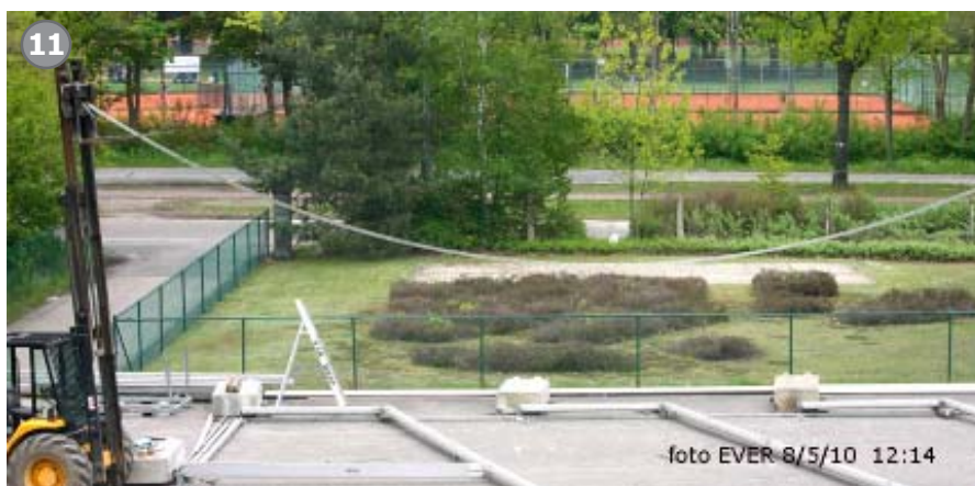
Vorklift met een soort hijsband die zowel aan de vorklift als aan de constructie was geknoopt -foto 3 en 4-
