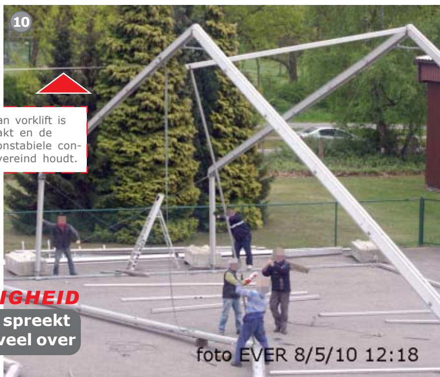
Tent voor 1000 personen in opbouw, de spanten voor de overspanningen wegen 450 kg, verbindings-elementen worden ingehaakt met zelfgemaakte "open" gaffels, niemand draagt een helm en diverse helpers hebben geen éneke opleiding voor dergelijke mechanische opbouw, zoals het gebruik van gereedschap en arbeidsmiddelen, zoals ratelsleutels voor moeren M16 -maat 24-, etc.
