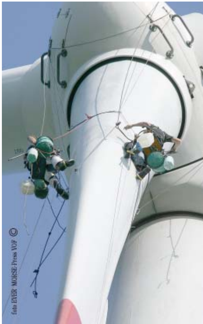
Met behulp van alpinistenteknik worden de wieken lgekuist.
